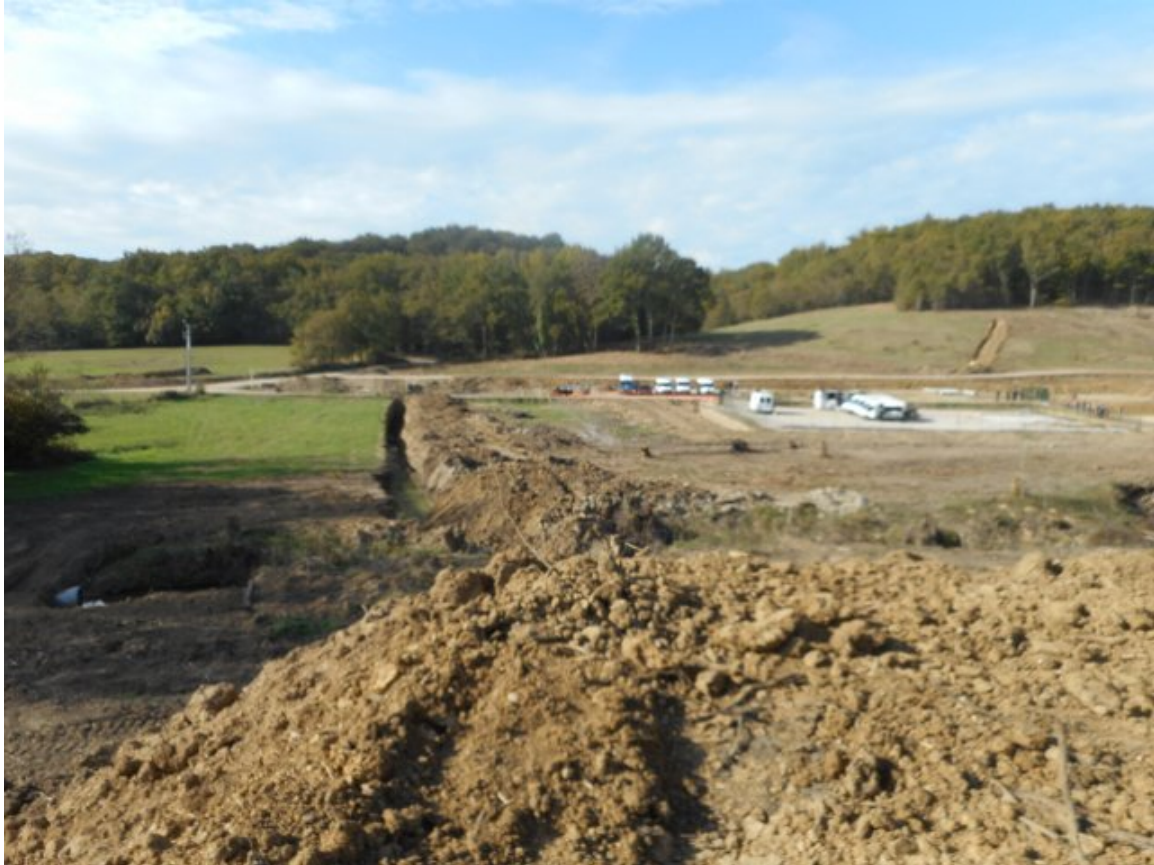
Photo 3 le 25/10/2014 15:41 vue depuis le sommet du remblais rive gauche
