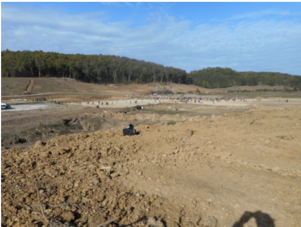
Photo 4 le 25/10/2014 15:41 vue depuis le sommet du remblais vers la rive droite
