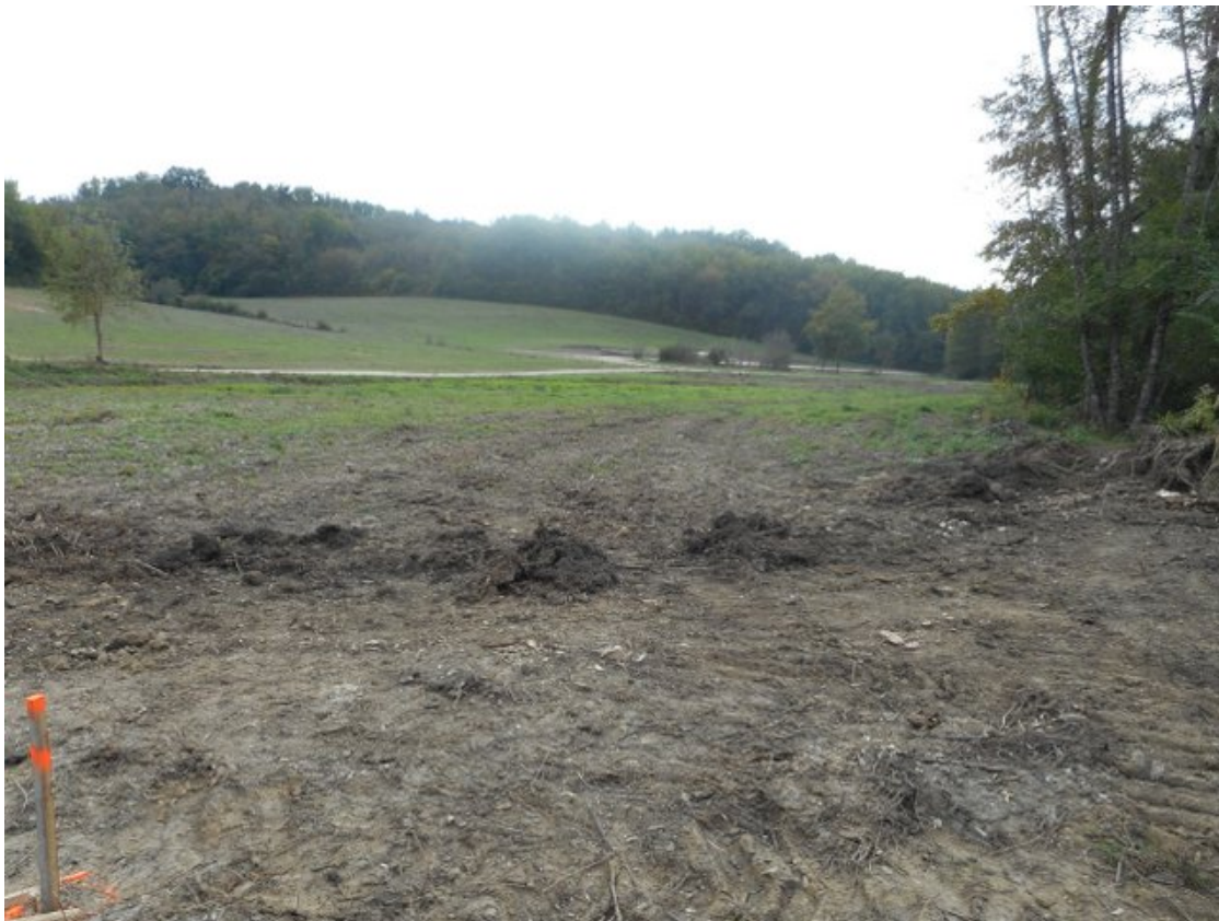
Photo 8 le 25/10/2014 16:05 sol remanié et tassé au premier plan , nouvelle piste en arrière plan
