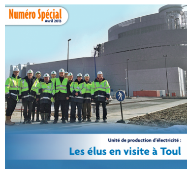
Des élus du pays de Landivisiau visitent la centrale à gaz de Poweo à Toul (DR)
