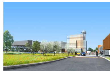
Vue de la future centrale de Landivisiau.
